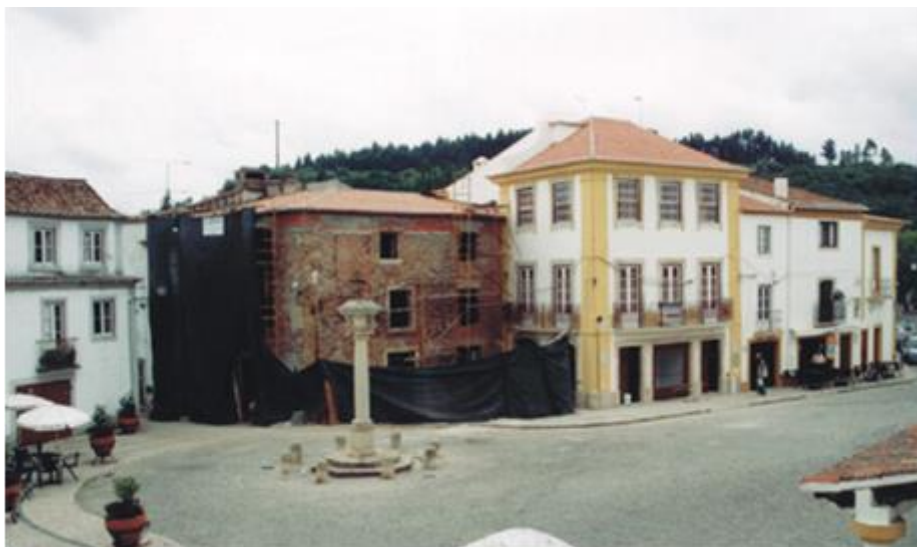
Fotografia 3 – Reabilitação de um edifício na Praça Alexandre Herculano
